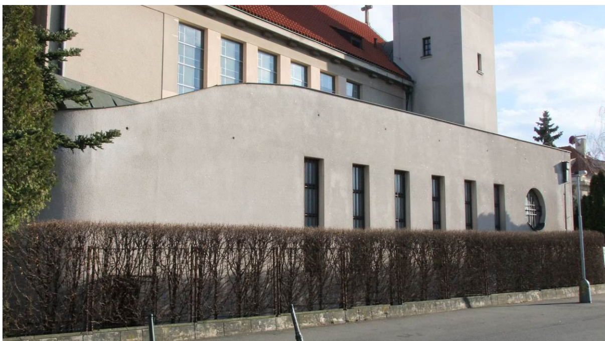
přístavba kaple Božského Srdce Páně, pohled z ulice Ve Lhotce
