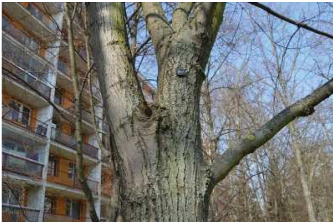
Mírné poškození v kosterním větvení, rychlejší růst kodominantní větve
